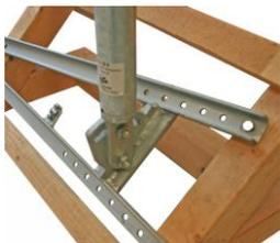
Das Dachblech mit Mastdurchführung ist nun wieder abzunehmen. Es werden die Löcher für die Sechskant - Holzschrauben (8x100) vorgebohrt. Der ADH 81 wird mit den 3 beiliegenden Holzschrauben auf den Dachsparren festgeschraubt. Sollten die Auflager nicht direkt auf die Dachbalken geschraubt werden, z.B. wegen einer Hartschaumisolierung, sind entsprechend um den Abstand zum Dachbalken längere Schrauben zu verwenden.
