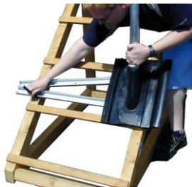
Das Dachblech mit Mastdurchführung probeweise über den Mast stülpen. Der ADH 81 wird auf den Dachsparren in seiner Höhe so verschoben, dass die Dachpfanne mit Mastdurchführung auf der Dachlatte in der Höhe so zu liegen kommt, dass der senkrecht stehende Mast durch die Durchführung der Dachpfanne passt. Die Lage des horizontalen Schenkels auf der Dachlatte wird nun markiert.
