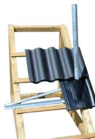
In dieser Höhe wird der ADH 81 nun so horizontal verschoben, dass das Dachblech mit Mastdurchführung genau in das Ziegelraster passt. Nun werden die Löcher für die 3 Sechskant - Holzschrauben markiert. 2 Holzschrauben werden bei der Seite angebracht, bei der die Schenkel auseinander zeigen.
