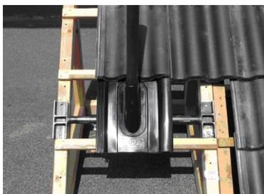
Das Mastrohr wird auf dem Teleskoprohr horizontal so verschoben, dass die Dachpfanne mit der Mastdurchführung mittig in das Dachziegelraster passt.
