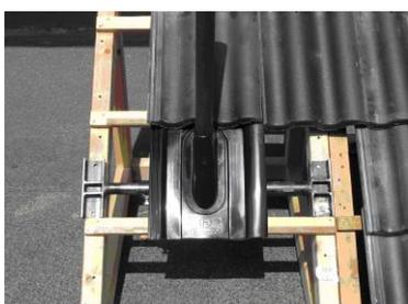
Die Montage erfolgt unterhalb der Dachpfannen auf den Dachsparren. Zunächst werden die Dachpfannen im Bereich, in dem der ADH montiert werden soll, entfernt. Das Teleskoprohr auf den Abstand der Dachsparren einstellen, so dass die Flansche voll auf den Dachsparren aufliegen.
